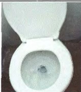
Foto 9: Sustitución de inodoro
