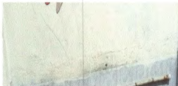
Foto 12: Pintura de muros de exteriores e interiores
