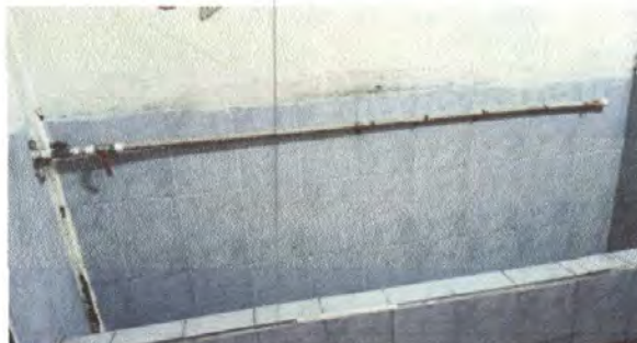
Foto 8: Sustitución migitorio por cemento más azulejo
