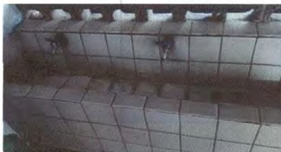
Foto 6: Sustrucción de lavamanos
