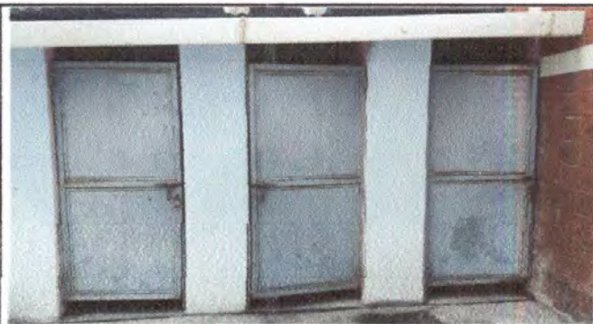
Foto 3: lijado y pintado de puertas de baño
