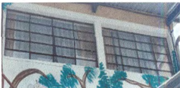
Foto 11: Sustitución de estructura de metal de ventana pvc
