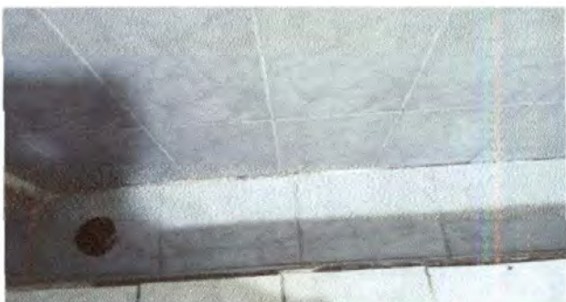
Foto 7: Sustitución de azulejo de baños de niños y niñas
