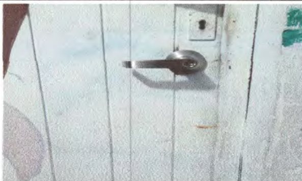
Foto 4: Sustrucción de puertas del servicio sanitario
