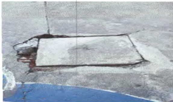
Foto 2: Sustrucción caja de registro
