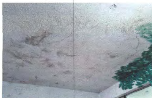
Foto 10: Impermeabilizante de losa
